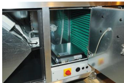
Automaatika „EASY” kontrolleri sisevaade
