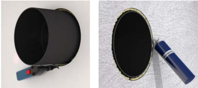
Setzen Sie die Unterschale der Außenwandhaube im Abstand  $x = 33 \text{ mm}$  zentrisch auf das PVC-Wandeinbaurohr und richten Sie sie an der Fassade in waagerechter Lage aus. Übertragen Sie die Bohrlöcher und bereiten Sie für die vier als Langloch ausgebildeten Befestigungspunkte eine geeignete Befestigungstechnik gemäß der Fassadenkonstruktion vor.
